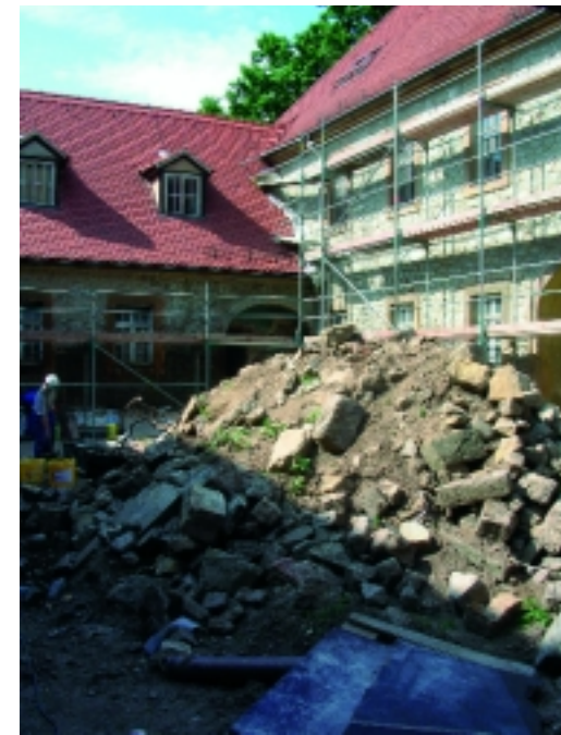
Baustelle auf dem Innenhof
